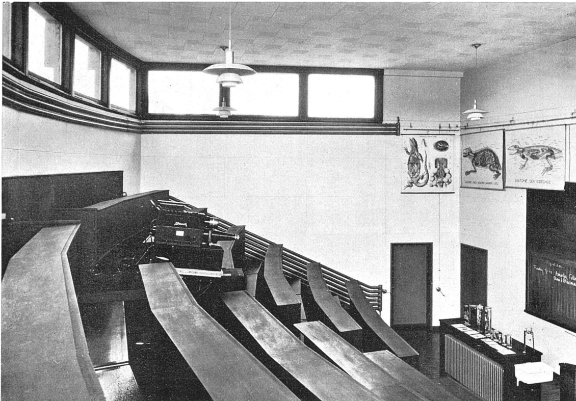
Typus der Hörsäle mit hoher, dreiseitiger Lichtzone mit Verdunklungseinrichtung Fensterrahmen und Heizröhren sind mit lebhaften Farben gestrichen
