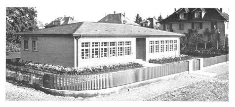
Holzriegelbau, aussen verschindelt, innen Sperrholzplattenverkleidung, Zwischenschalung, Eternitdach. Als Decke der Klassenzimmer und des Vorplatzes Celotexplatten. «Freie Bestuhlung». Der Turnunterricht wird auf dem Rasenplatz abgehalten, der Schulunterricht im Sommer unter der grossen Baumgruppe. Baukosten Fr. 65,000, einschliesslich Umgebungsarbeiten und Mobiliar.
