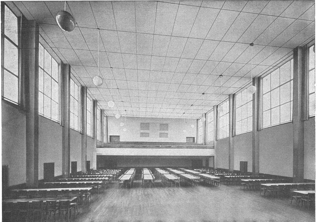
LIMMATHAUS ZÜRICH 1000 m 2 als Deckenverkleidung
