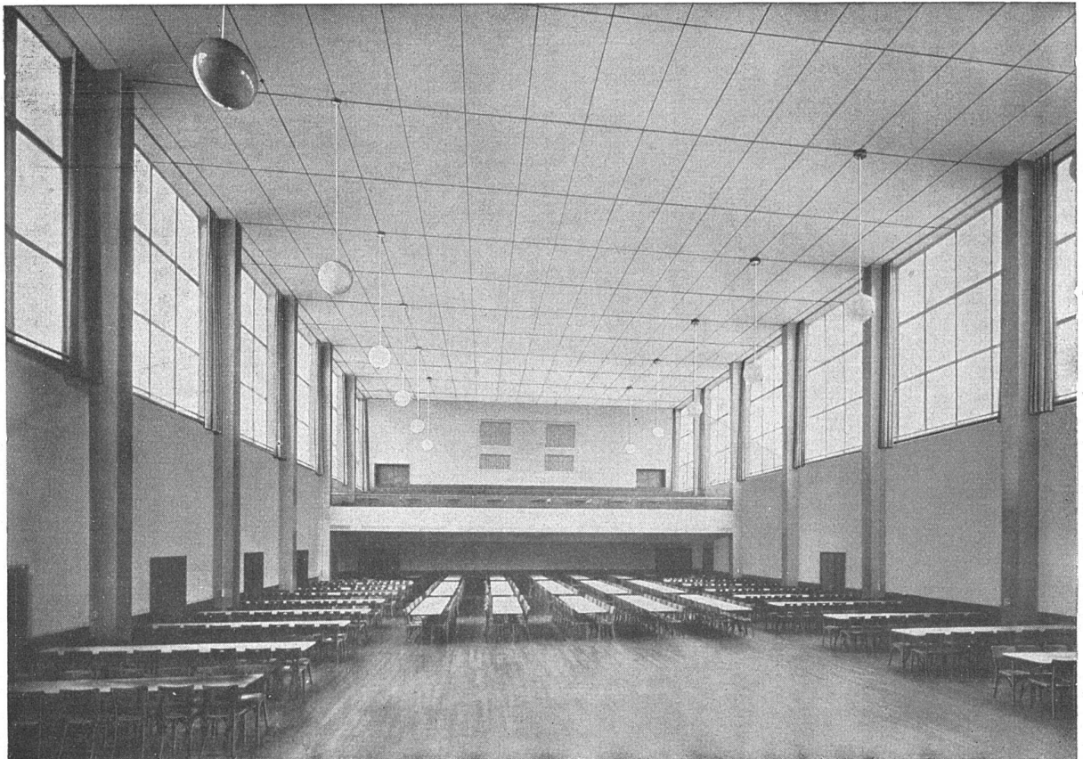
LIMMATHAUS ZÜRICH 1000 m 2 als Deckenverkleidung
