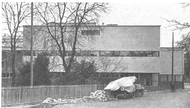
Bâtiment du Désarmement, Genève Ad. Guyonnet, arch. FAS, et prof. L. Perrin, ingénieur, Genève
