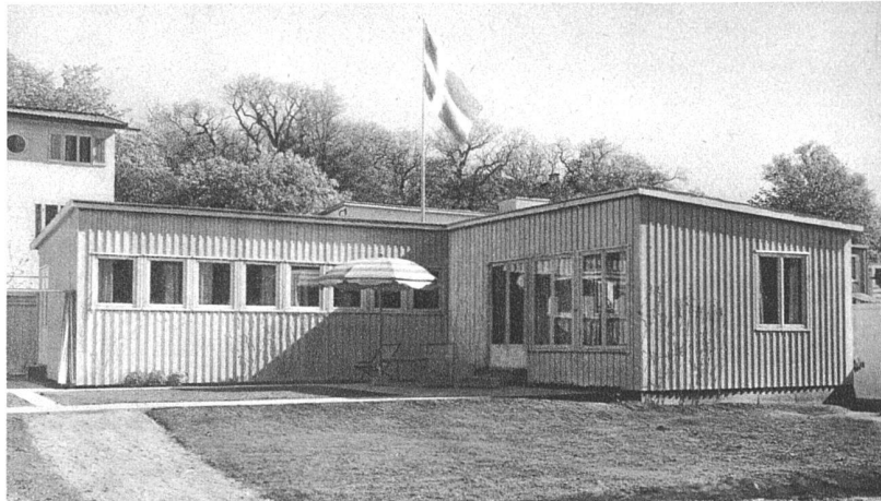
Einfamilienhaus, Stockholmer Ausstellung 1930. Von Südost. Architekt Swen Markelius Skelettplattenbau (Täta). Dach Doppelpappe
