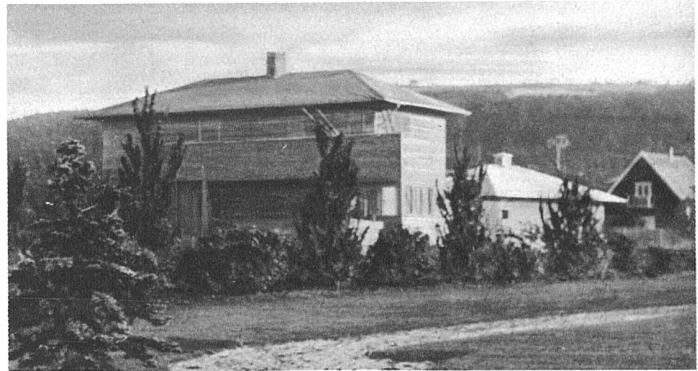
Einfamilien-Sommerhaus, Bastad. Rohbau von Nordwest Architekt Birger Jonsson, Stockholm. Plankenbau, Schieferdach
