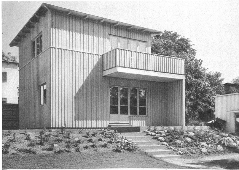
Einfamilienhaus, Stockholmer Ausstellung 1930. Von Südwest. Architekt Birger Jonsson Plankenplattenbauweise (Sesam)
