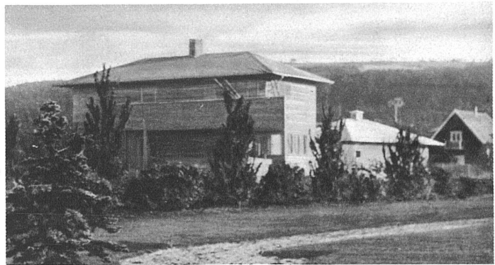
Einfamilien-Sommerhaus, Bastad. Rohbau von Nordwest Architekt Birger Jonsson, Stockholm. Plankenbau, Schieferdach
