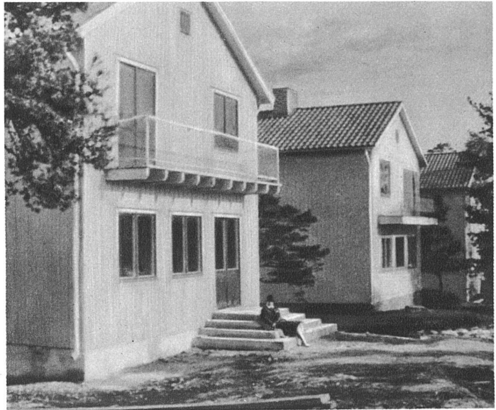
Drei Einfamilienhäuser, Äppelviken 1927. Architekt Uno Ahrén, Stockholm Plankenbau. Balkon auf hochkant gestellten Balken
