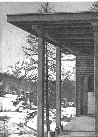
Vorplatz, Blick nach Westen
