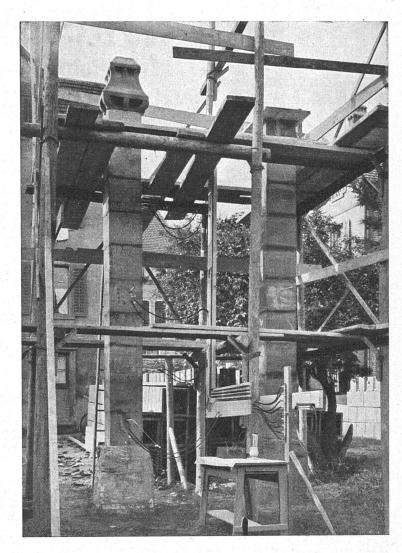
Versuchsanordnung für Brand- und Druckproben von Vulkan-Kaminen an der Eidg. Materialprüfungsanstalt der E. T. H. Zürich
