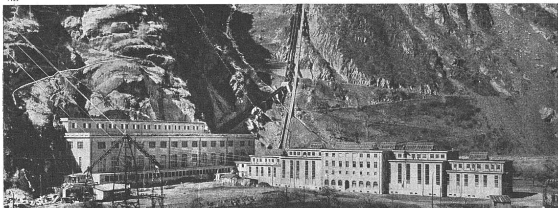
Beim Bau des Schalthauses Vernayaz traten die Vorteile des Stahlbaus so richtig zu Tage. Trotz strengstem Winter kein Unterbruch der Arbeiten; trotz äußerst schlechtem Baugrund keine kostspieligen Fundamente — klar und ruhig gegliedert steht der fertige Bau da: grösste Widerstandsfähigkeit gegen Feuer und Steinschlag, den inneren Installationsverhältnissen aufs beste entsprechend, bereit, auch künftigen Betriebsveränderungen sich anzupassen. Auskunft über den Stahlbau erteilt
