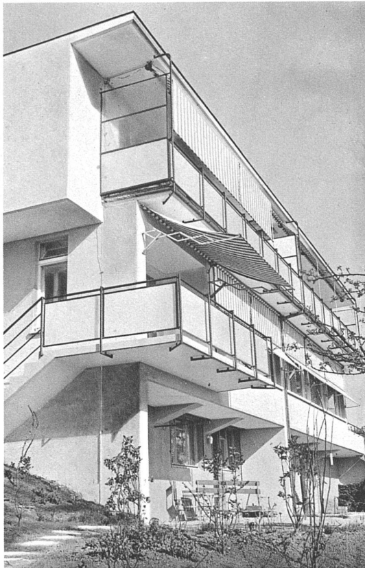
Westecke, Balkone nach Südwesten
