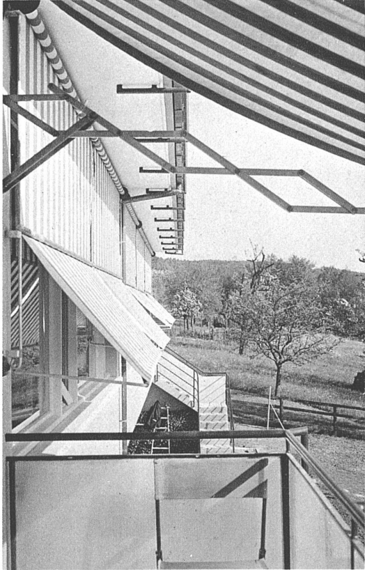
Südwestfassade, als Balkonbrüstungen Drahtglasscheiben, mattiert, in Eisenrahmen
