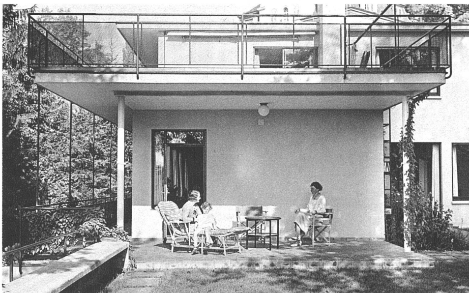
Esszimmervorbau von Südosten
