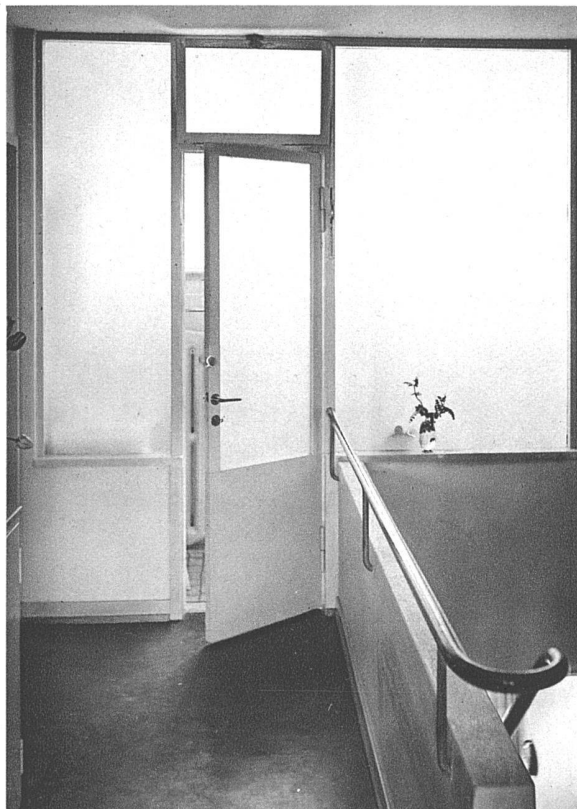
Treppenhaus, Tür zum Waschraum
