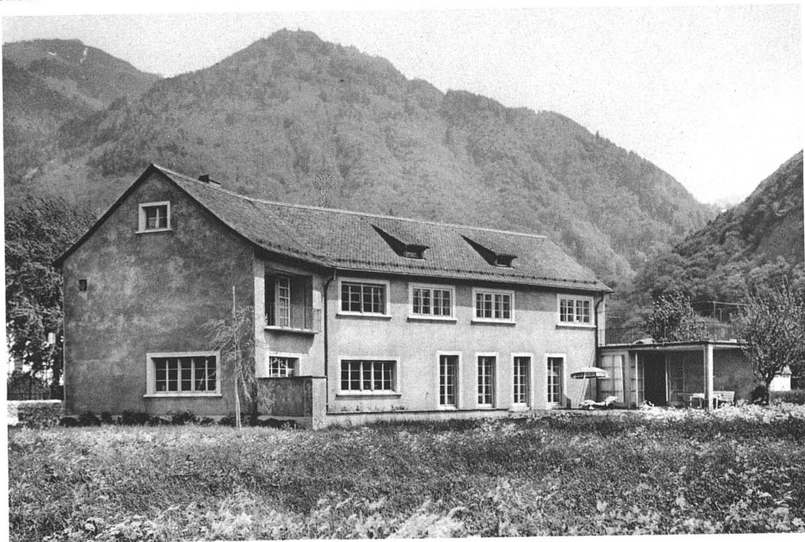
Ansicht aus Südwesten
