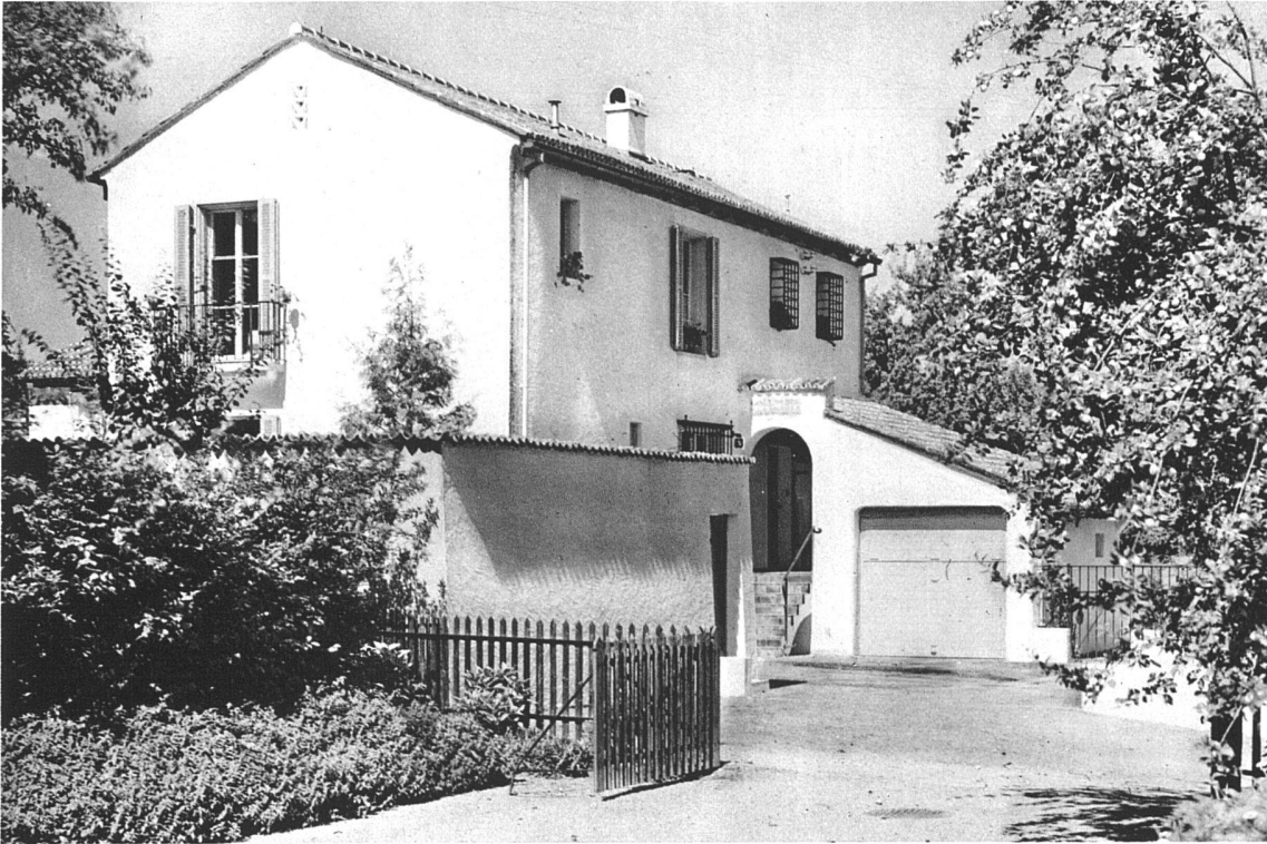
Ansicht von Südosten Eingangsseite
