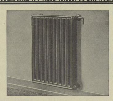
Beste Ausführung erfordert Wandfüsse und verdeckte Anschlüsse Spezialhahn (Oederlin) und Rücklauf-Verschraubung
