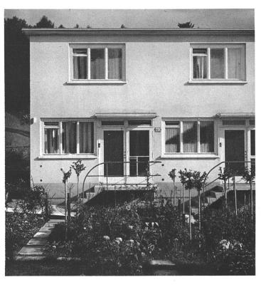
Typ D Rückseite (Eingangsseite) Abgetrennte Südnischen: 1,20 m breite Drahtglaswände, 3,20 m tiefer Plattenbelag vor der ganzen Hausbreite, 1,80 m weit ausladende Markisen
