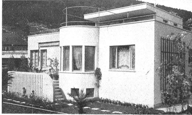
Haus in Holzbeton an der Ländtstrasse, Biel Otto Schaub, Ing., Biel
