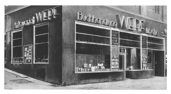
Fassaden im Erdgeschoss, verkleidet mit schwarzem, poliertem \*Le Lap», Metallteile und Schriften in Anticorodal
