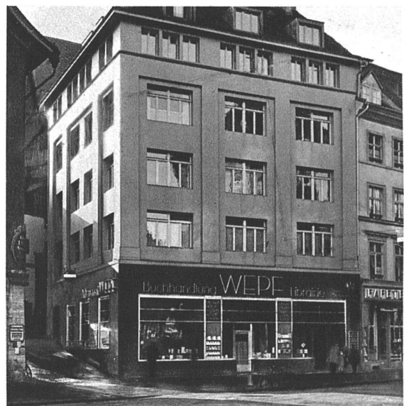
Nach dem Umbau
