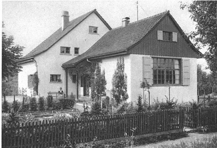
Ansicht aus Nordost
