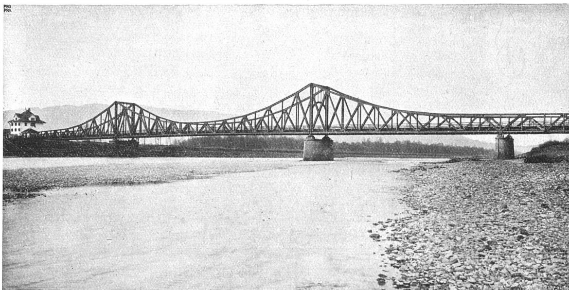
Strom-Brücke aus Stahl für schweren Verkehr. Wirkt durch die Eleganz der Linienführung. Grosses Spannweiten — 93 Meter! Wenig Pfeiler. Beim Bau minimale Versperrung des Flusses durch Gerüst-Einbauten. Vorteilhafte Anpassung an die Umgebung. Auskunft über den Stahlbau erteilt
