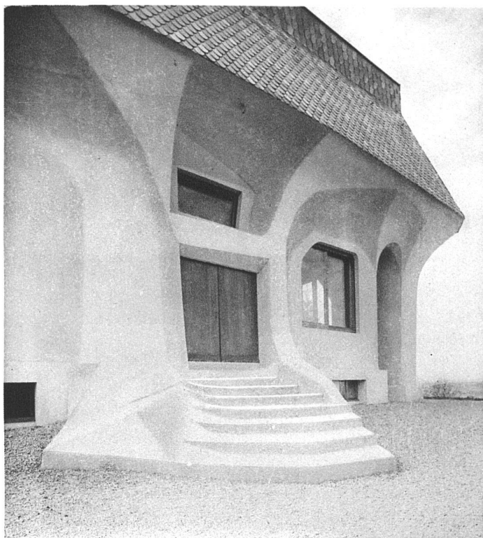
Dornach «Eurythmeum», Schule für Sprachgestaltung. Nordseite, unten Westseite mit Haupteingang, erbaut 1923 nach Entwurf von Rudolf Steiner. Stampfbeton und Backsteinmauerwerk, Dachkonstruktion in Holz, gedeckt mit norwegischem Schiefer. Weitere Anmerkungen zu diesem Gebäude siehe S. 129
