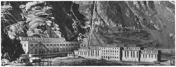
Beim Bau des Schalthauses Vernayaz traten die Vorteile des Stahlbaues so richtig zu Tage. Trotz strengstem Winter kein Unterbruch der Arbeiten; trotz äusserst schlechtem Baugrund keine kostspieligen Fundamente — klar und ruhig gegliedert steht der fertige Bau da: grösste Widerstandsfähigkeit gegen Feuer und Steinschlag, den inneren Installationsverhältnissen aufs beste entsprechend, bereit, auch künftigen Betriebsveränderungen sich anzupassen. Auskunft über den Stahlbau erteilt
