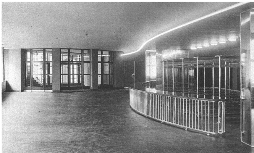
Vorplatz und Garderobe vor dem grossen Börsensaal Die Pfeiler enthalten ausser den Stützen auch die Lüftungskanäle
