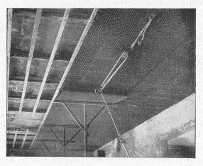
Isolationsdecke aus Drahtziegelgewebe unter Hohlkörper
