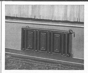
**Beste** Ausführung erfordert Wandfüsse und verdeckte Anschlüsse Spezialhahn (Oederlin) und Rücklauf-Verschraubung
