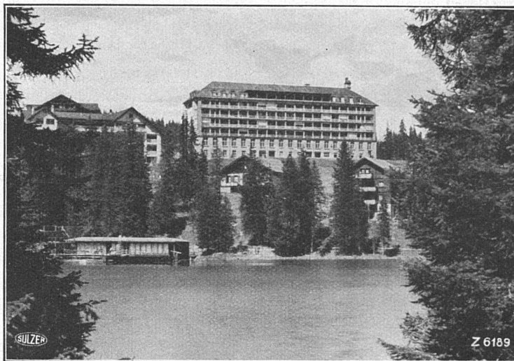
Sanatorium „Altein“ Arosa, ausgerüstet mit Sulzer-Heizungsanlage
