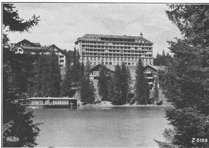
Sanatorium „Altein“ Arosa, ausgerüstet mit Sulzer-Heizungsanlage
