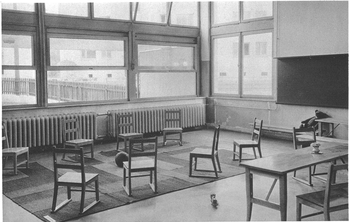
Block 16 Kindergarten der Siedlung «In den Schorenmatten» A. Künzel und Artaria & Schmidt, Arch. B.S.A., Basel
