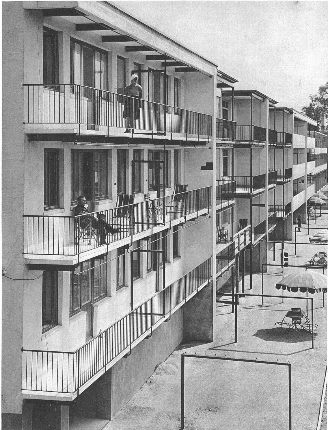
Ausstellungs-Siedlung Eglisee der WOBA Basel Block 4, 3 und 21 von der Gartenseite
