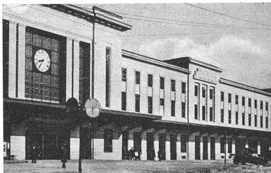
La nouvelle gare de Cornavin
