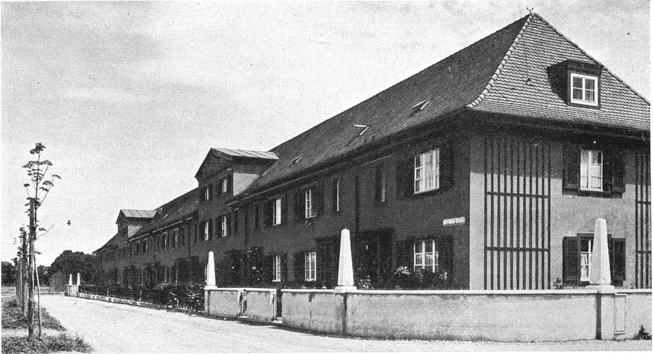
HÄUSERZEILE AN DER KLEINRIEHNSTRASSE / ARCHITEKTEN VON DER MÜHLL UND OBERRAUCH B. S. A.
