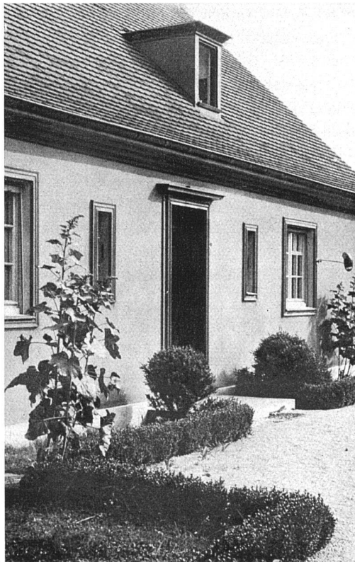
EINGANGSPARTIE DES EINGESCHOSSIGEN HAUSES
