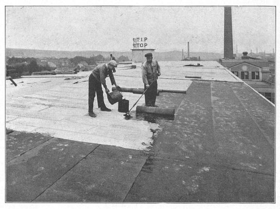
Dachisolierung der Schuhfabrik «Tip-Top» Verwendung fanden 1050 m² Heraklithplatten in 5 cm Stärke
