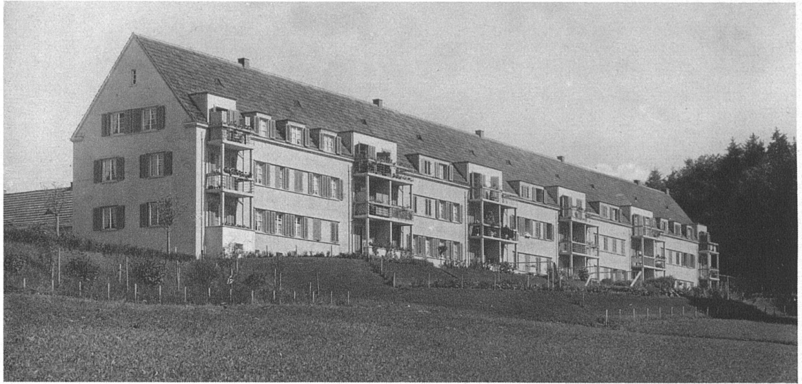
Wohnkolonie Entlisberg der Allgemeinen Baugenossenschaft Zürich Architekten Schneider & Landolt, Zürich
