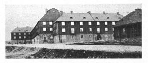
Grosser Block mit Wohnungen an den Strassen Härlandvägen und Stockholmsgatan Erdgeschoss massiv, zwei Obergeschosse in Holzkonstruktion, erbaut\_1919—1922
