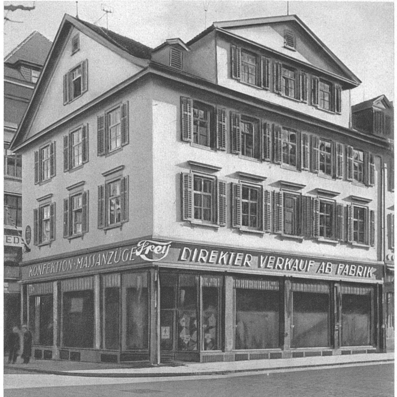
Ladeneinbau in St. Gallen
