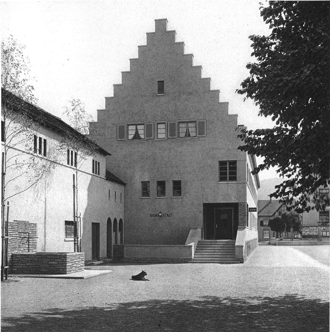
WERKHOFGEBÄUDE NEUHAUSEN / GIEBEL MIT HAUPTINGANG / ARCHITEKTEN SCHERRER & MEYER
