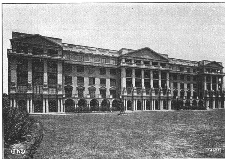
Country Hospital in Shanghai, ausgerüstet mit Sulzer-Ventilationsanlage.
