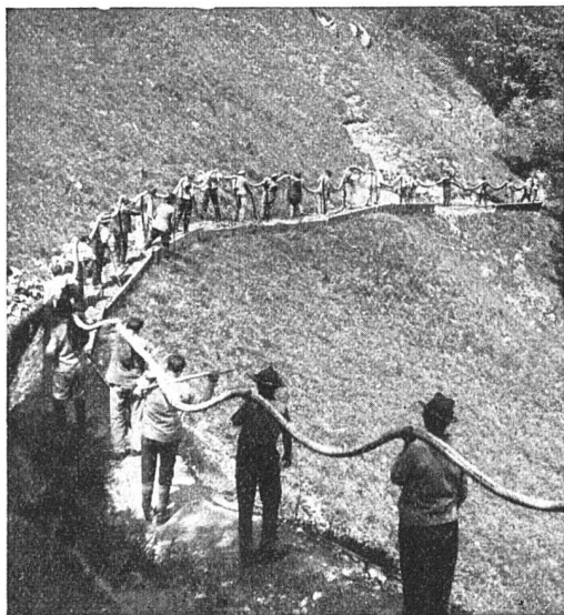
Fernkabelverlegung am Walensee
