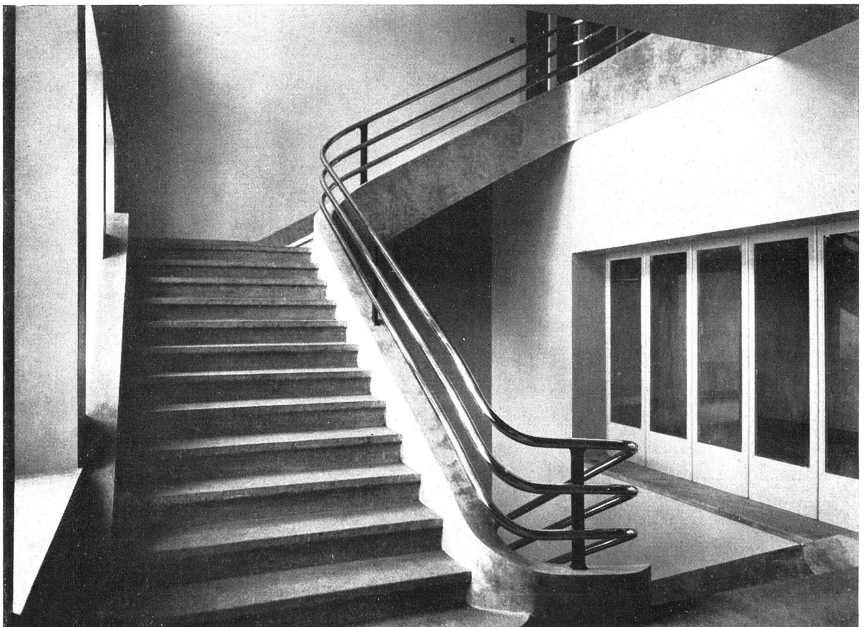
LORYSPITAL / GRANITTREPPPE MIT STUCCOLUSTRO-WANGE UND NICKELGELÄNDER
