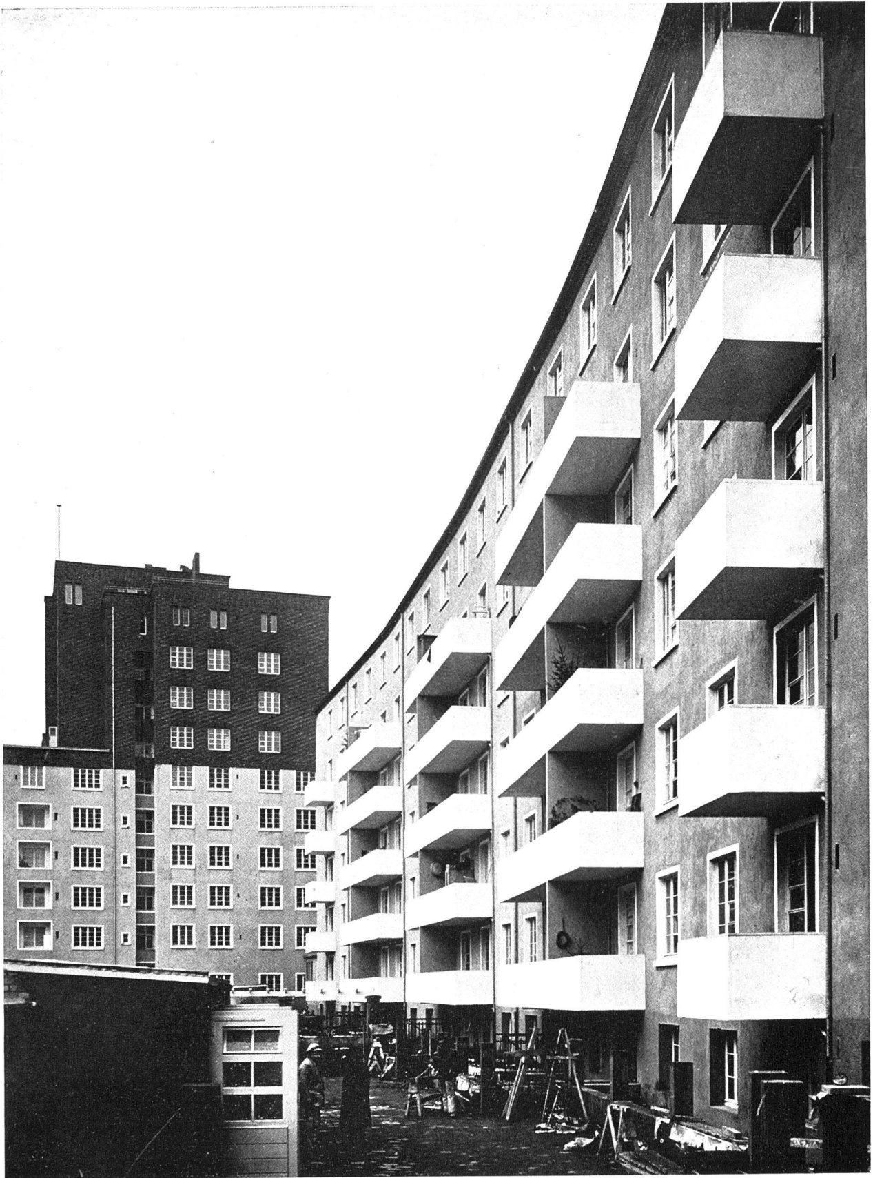
BRÜCKENKOPFBAUTEN DÜSSELDORF / NORDBAU, HOFANSICHT
