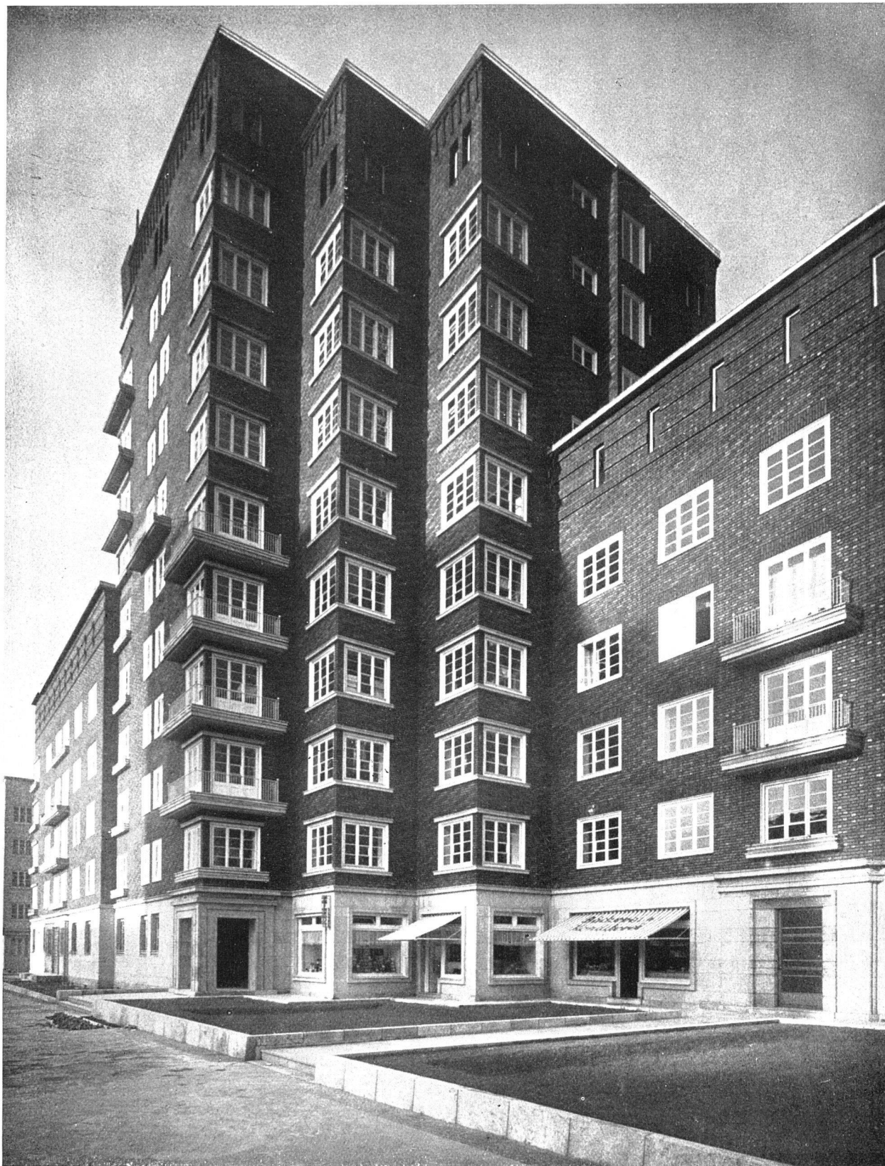
PROF. DR. ING. W. DUNKEL / BRÜCKENKOPFBAUTEN DÜSSELDORF / NORDBAU Sockelgeschoßverblendung in Tuffstein, darüber Verblendung in Klinker / Zargenfenster
