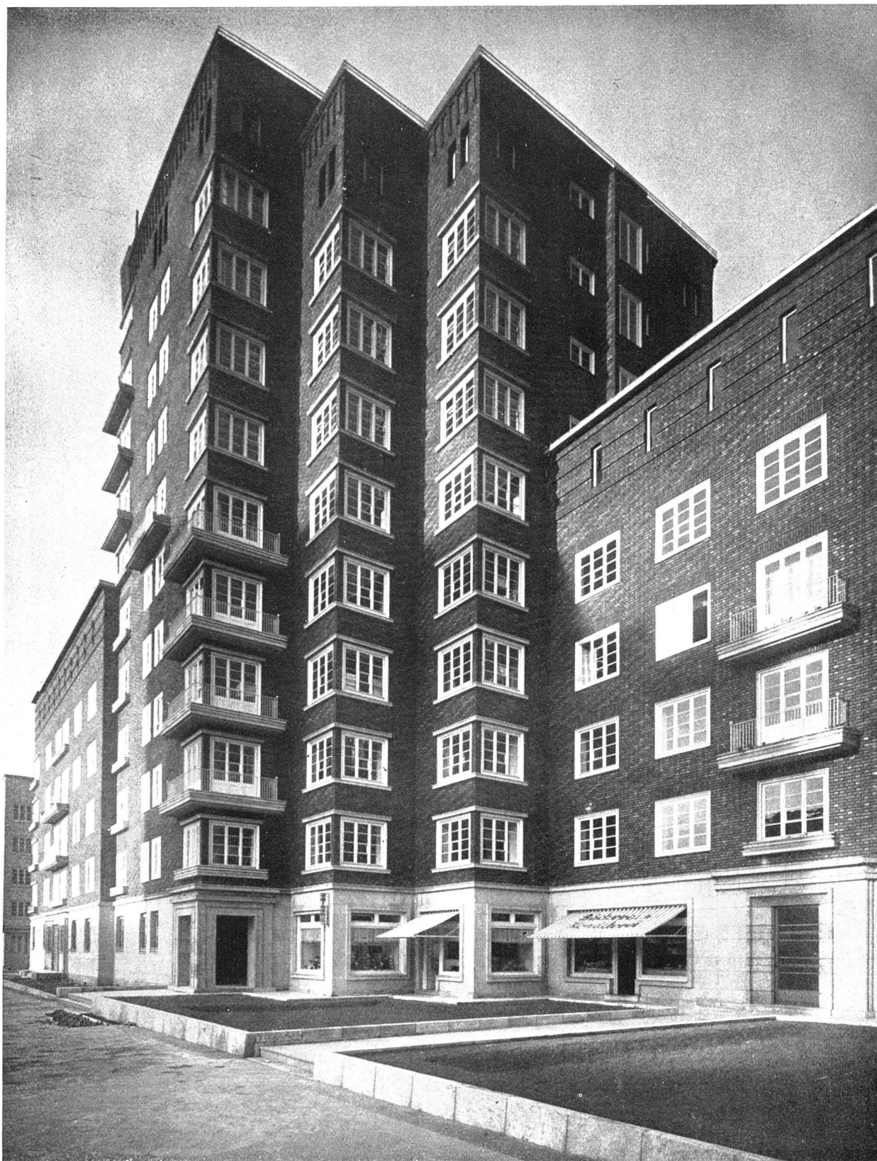
PROF. DR. ING. W. DUNKEL / BRÜCKENKOPFBAUTEN DÜSSELDORF / NORDBAU SockelgeschöÙverblendung in Tuffstein, darüÙber Verblendung in Klinker / Zargenfenster
