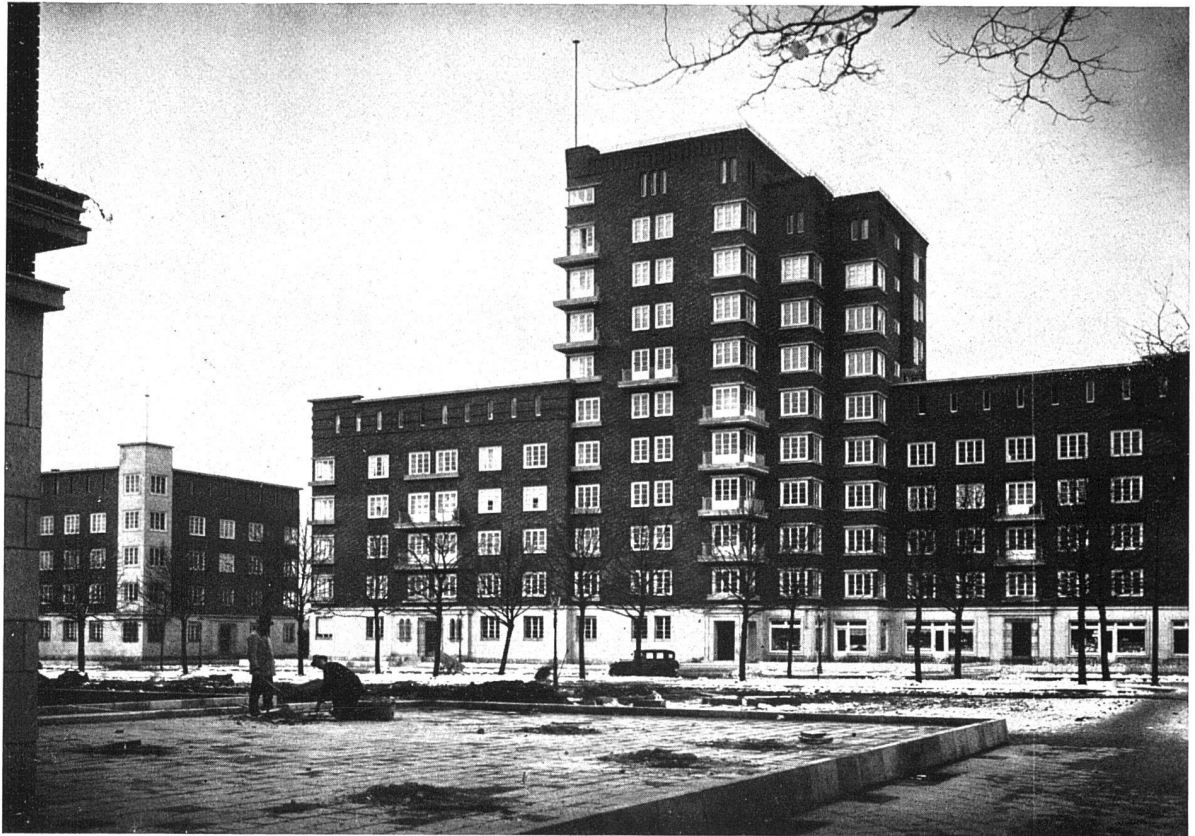
BRÜCKENKOPFBAUTEN DÜSSELDORF / GESAMTANSICHT DES NORDBAUES
