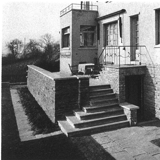
GARTENAUFGANG AUF DER SÜDSEITE DES HAUSES
