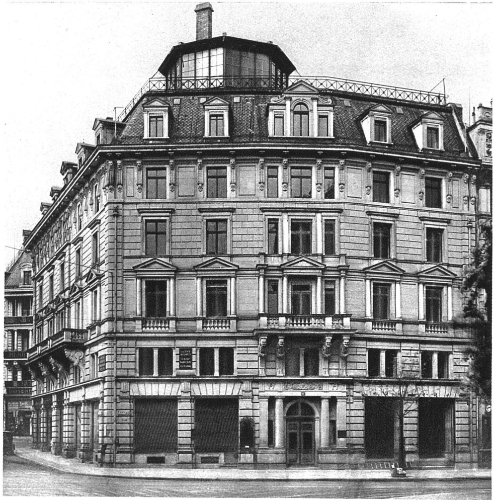
SCHUHHAUS CAPITOL, BAHNHOFSTRASSE, ZÜRICH / VOR DEM UMBAU FASSADE BAHNHOFSTRASSE
