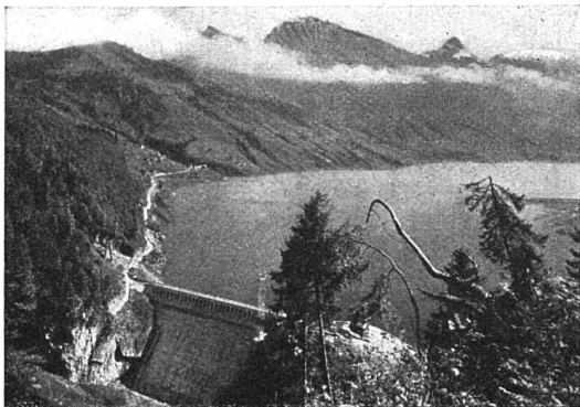
Staumauer Schräg, Wäggitthal
