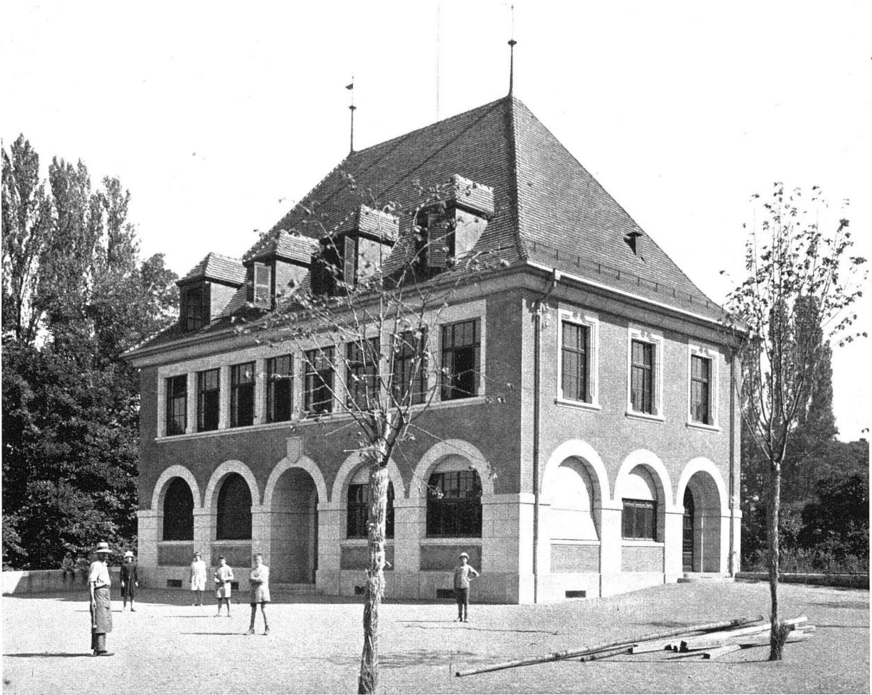
MAISON COMMUNALE, HERMANCE / VUE PRINCIPALE / FRÉDÉRIC MEZGER, ARCHITECTE F. A. S., GENÈVE
