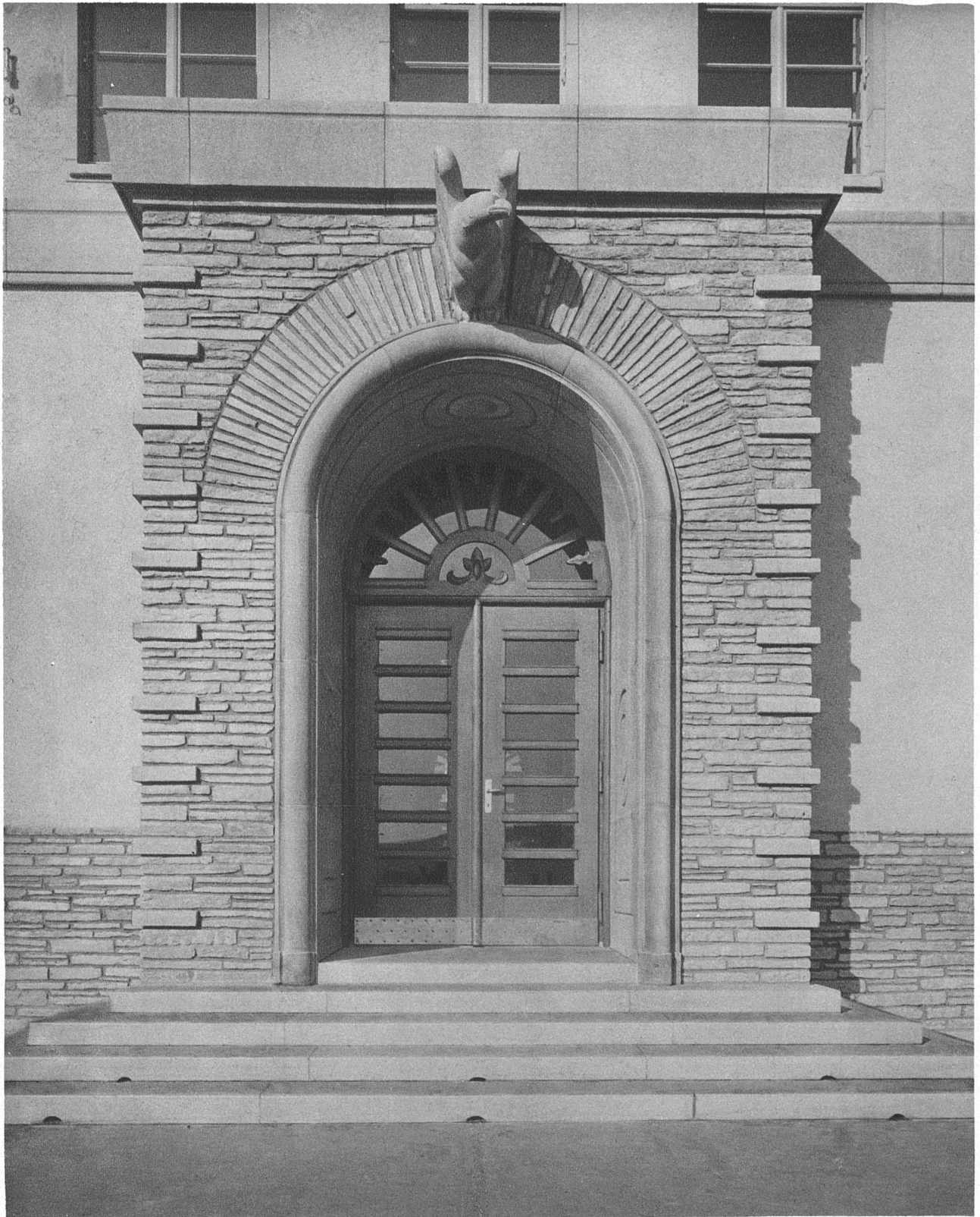
KANTONSSCHULE WINTERTHUR / HAUPTPORTAL / ZUGANG VON DER GROSSEN TERRASSE AUS Plastik von Karl Fischer S.W.B., Zürich
