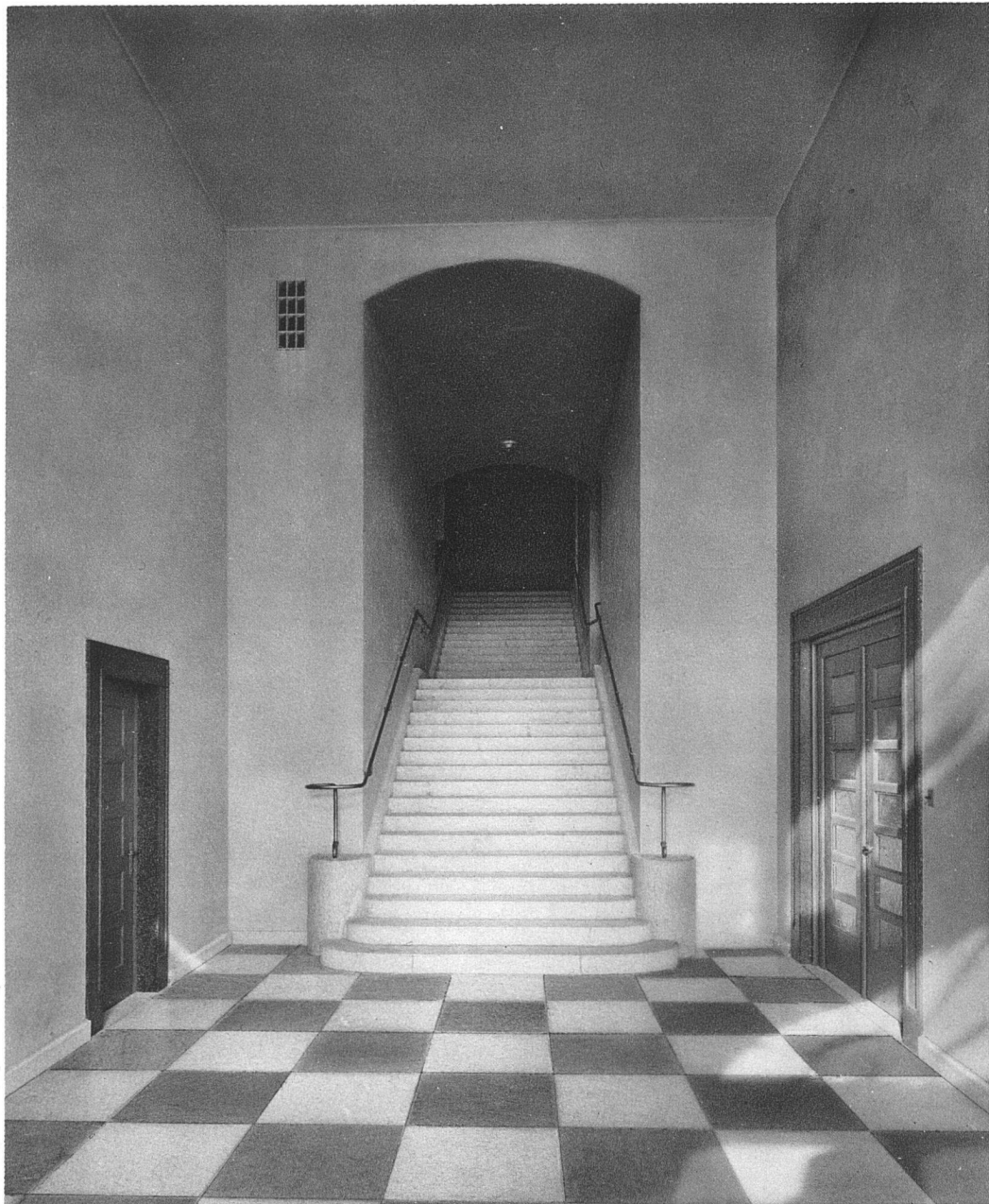
KANTONSSCHULE WINTERTHUR / AUFGANG VON DER UNTERN TERRASSE ZUM ERSTEN UNTERGESCHOSS Rechts Zugang zur Turnhalle
