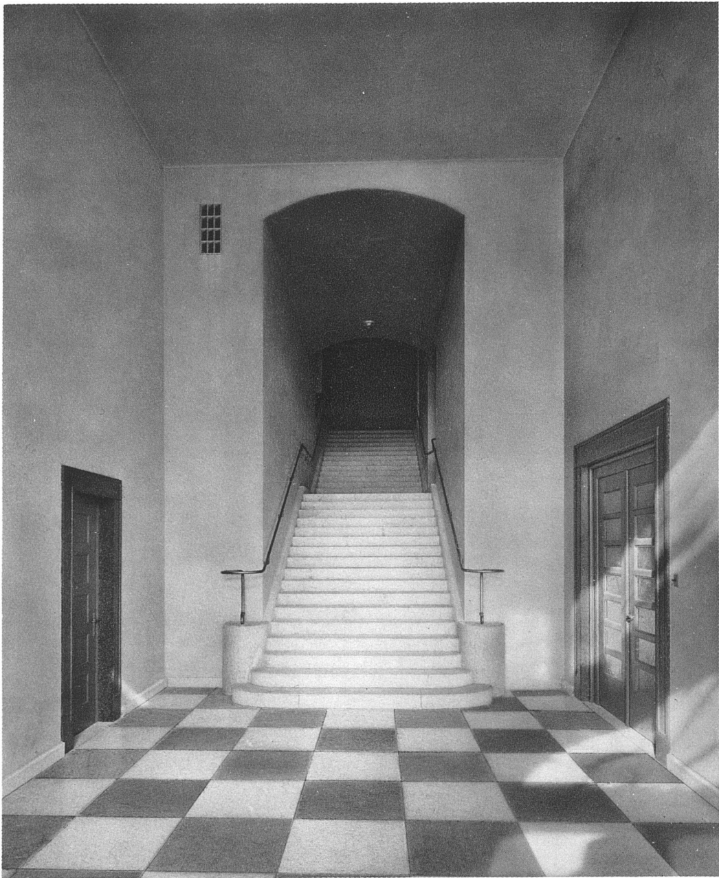
KANTONSSCHULE WINTERTHUR / AUFGANG VON DER UNTERN TERRASSE ZUM ERSTEN UNTERGESCHOSS Rechts Zugang zur Turnhalle
