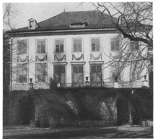
DAS MURALTENGUT DIE DEM SEE ZUGEWANDTE OSTFRONT Figur von Hermann Haller unten: ZUSTAND VOR DEM AUSBAU
