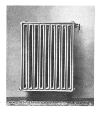
führungsformen von der nötigen Festigkeit und für gutes Zusammenfügen ergeben sich am besten aus Gusseisen. Gepresstes Blech eignet sich eher für gedrängte tiefere Gliederform, die dann fast ganz den Charakter des Lufterhitzers annimmt. Alles in allem ist daher Gusseisen, schon vermöge seiner guten Strahlung und der Widerstandsfähigkeit gegen Rost, das bestgeeignete und solidere Material, welches auch in bezug auf Gewicht heutzutage dem Blechradiator wenig nachsteht.
