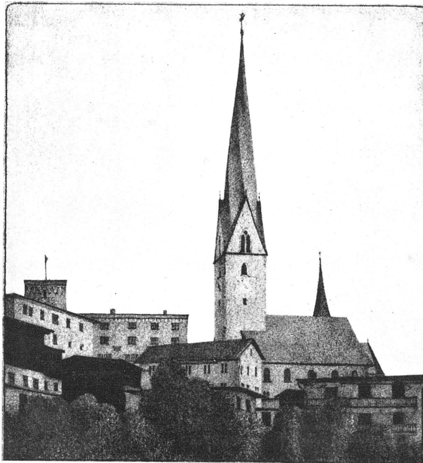
RATHAUS DAVOS MIT UMGEBUNG / NACH DEM UMBAU Vorschlag von Rudolf Gaberel, Architekt B.S.A.
