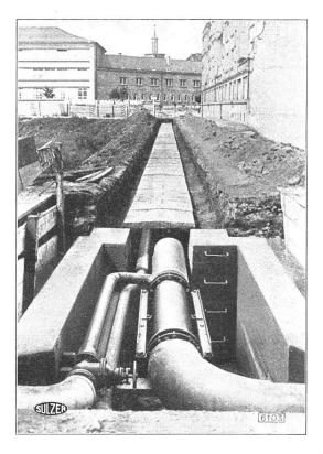
Kontrollschacht mit Rohrkompensator einer Sulzer-Fernheizung.
