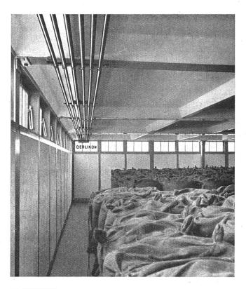
**LAGERRAUM**6 Linearheizröhren à 10 Meter / Leistung 8 kW
