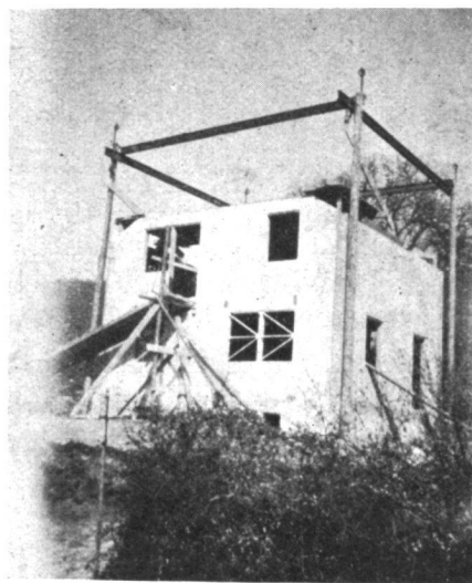
Einfamilienhaus / Rohbaufertig, zum Einbetonieren der Zwischendecken
