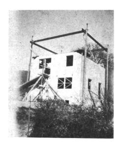
Einfamilienhaus / Rohbaufertig, zum Einbelonieren der Zwischendecken
