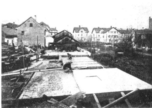
Garage / Betonieren der Wände
