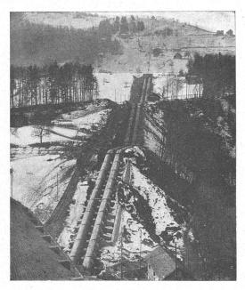
Abb. 9. Mit Nerol isolierte Druckrohrleitung.
