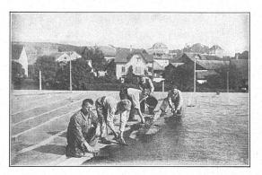
Abb. 7. Isolierung eines Daches mit Composit.
