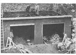
Abb. 6. Isolierung eines Garagedaches mit Asphaltoid.
