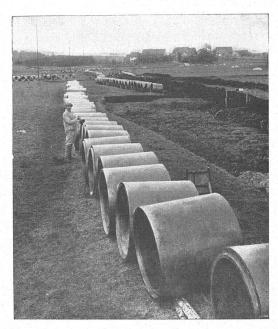
Abb. 8. Mit Nerol gestrichene Zementröhren für Bodenmelioration.
