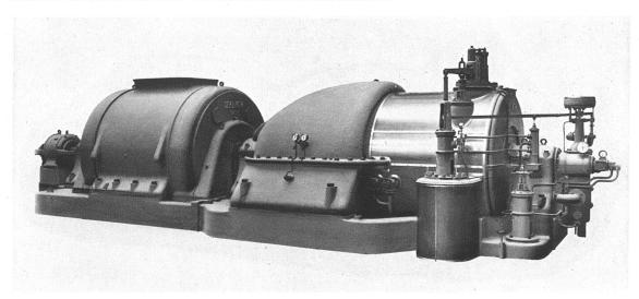
DAMPFTURBINE / ERSTELLT VON DER MASCHINENFABRIK OERLIKON
