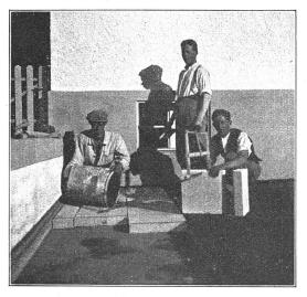
Abb. 12. Isotierung einer Terrasse über bewohnten Räumen an der Hadlaubstrasse in Zürich. Zellenbeton 8 cm stark, mit spez.
