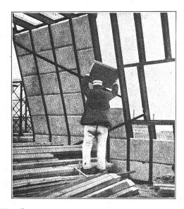
Abb. 8. Erweiterung eines Brauhauses, 340 m² Dach- und Wandplatten aus Zellenbeton, 8 cm stark, spez. Gewicht 0,7, bekleidet mit Verputz auf Drahtgeflecht und Dachpappe.
